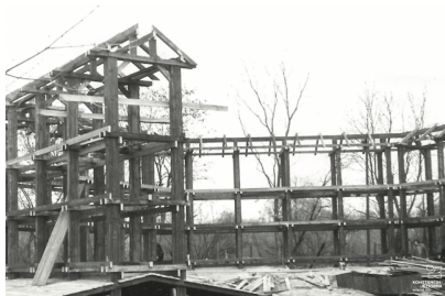
Tężnia w budowie – 1977 r. (fot. ze zbiorów E. Biały)
